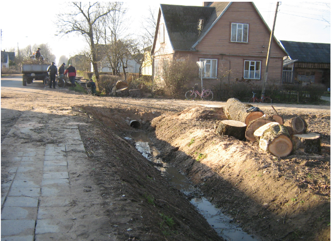
Rietavo pietvakarinės miesto dalies vandentiekio ir buitinės kanalizacijos statybos darbai. 2008 m.
