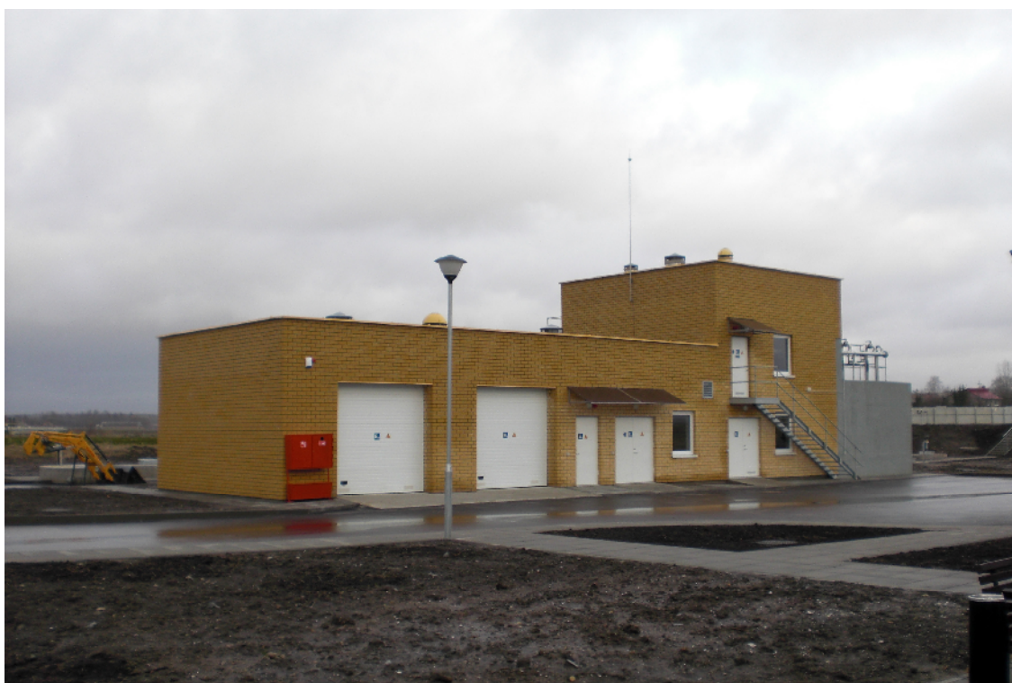
Rietavo miesto buitinių nuotekų valyklos rekonstrukcija. 2008 m.
