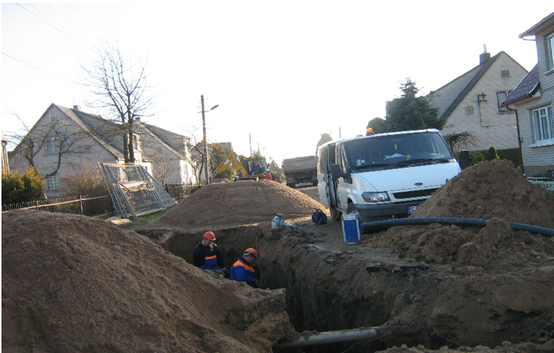
Rietavo pietvakarinės miesto dalies vandentiekio ir buitinės kanalizacijos statybos darbai. 2008 m.
